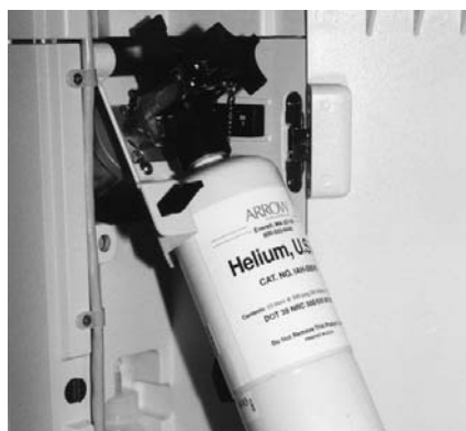
Figura 10.2: Botella de condensación detrás del tanque de helio
