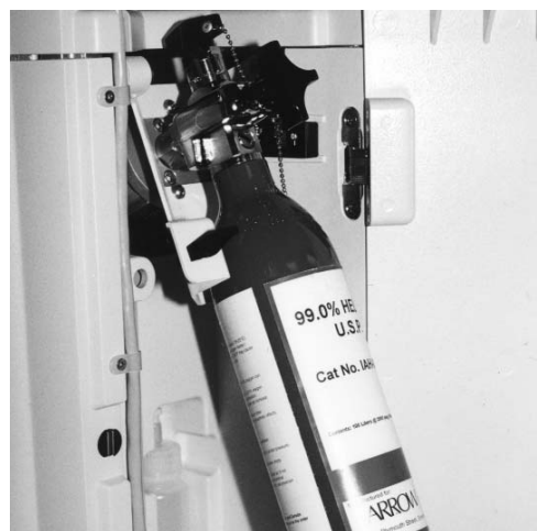
Figura 10.5: Instalación del tanque de helio rellenable de >2000 psi
